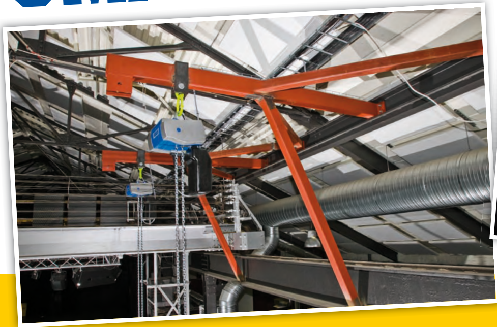
Manövreringen av telfrarna sköts av personalen via ett kontaktorskåp.
