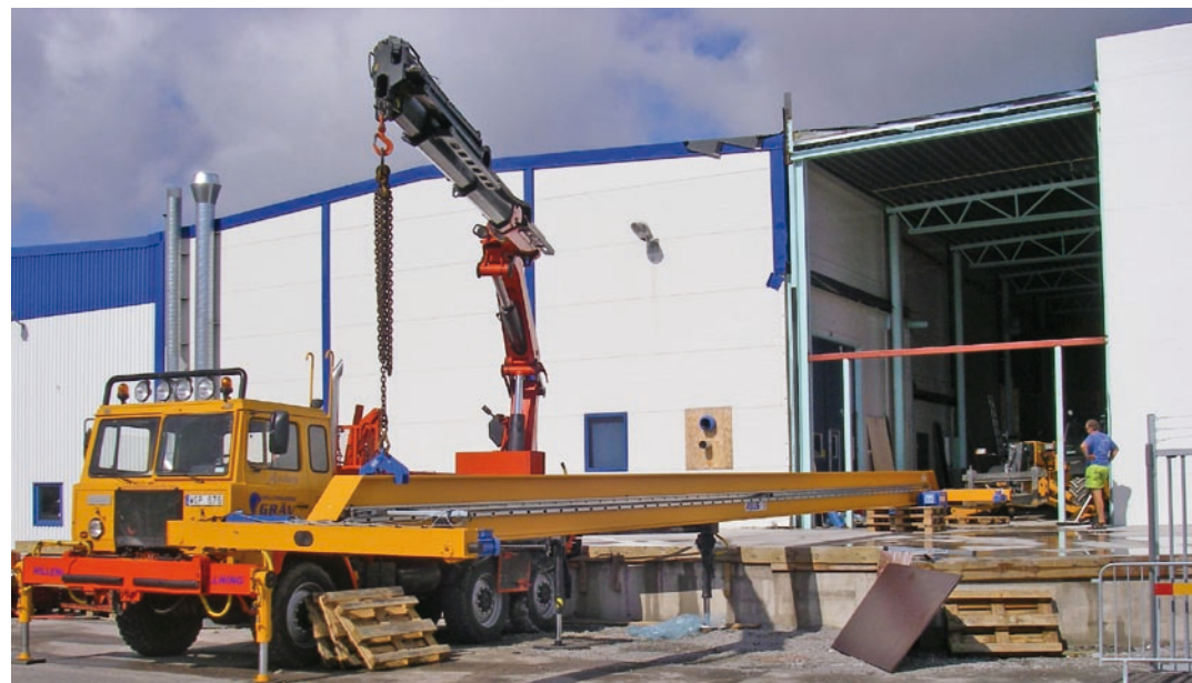
KILT AB i Trollhättan är en av JJ Gruppens viktiga samarbetspartners. Här installeras fem nya traverser från ABUS i Siemens nya utbyggda anläggning i Trollhättan.
