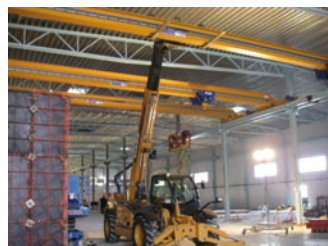
KILT AB i Trollhättan är en av JJ Gruppens viktiga samarbetspartners. Här installeras fem nya traverser från ABUS i Siemens nya utbyggda anläggning i Trollhättan.
