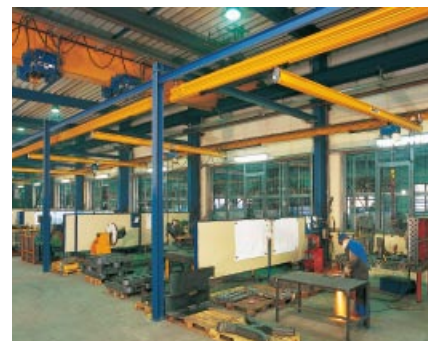
Upphängning via fristående stålkonstruktion
