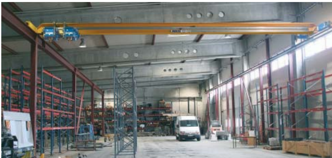
Internordisk Spännarmerings nya lokaler i Västerhaninge med den nya traversen och de två telfrarna i taket. Företaget ingår i Skanska-koncernen.
