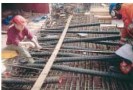
Inläggning av rör och kablar i Årstabrons broplatta.
