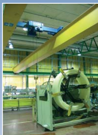
ABUS-traverserna hjälper till att lyfta Uponor Virsbo AB:s PEX-rör från en haspel, dvs den runda hållaren i mitten.
